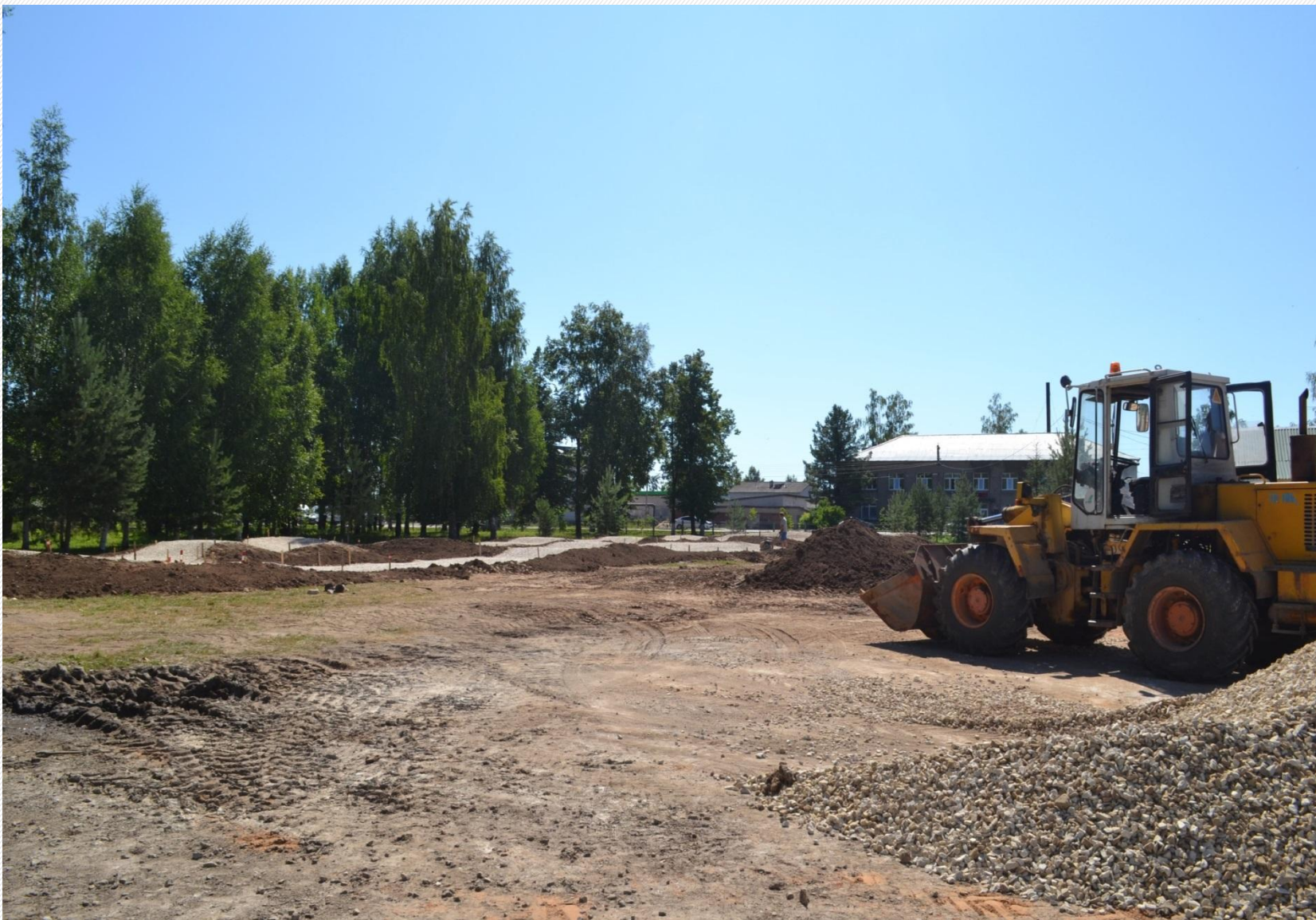
Строительство памп-трека в центральном парке
