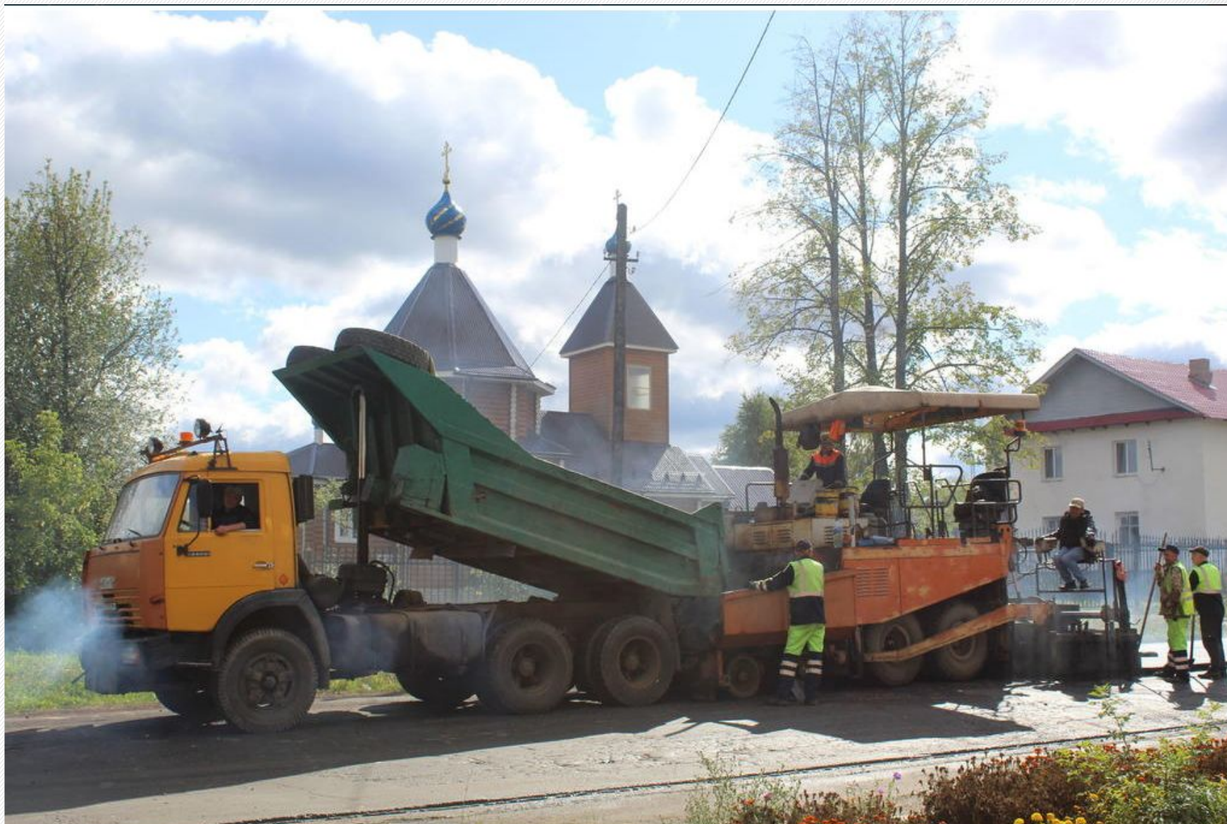
Ремонт дороги на ул. Коммунистическая в р.п. Тонкино
