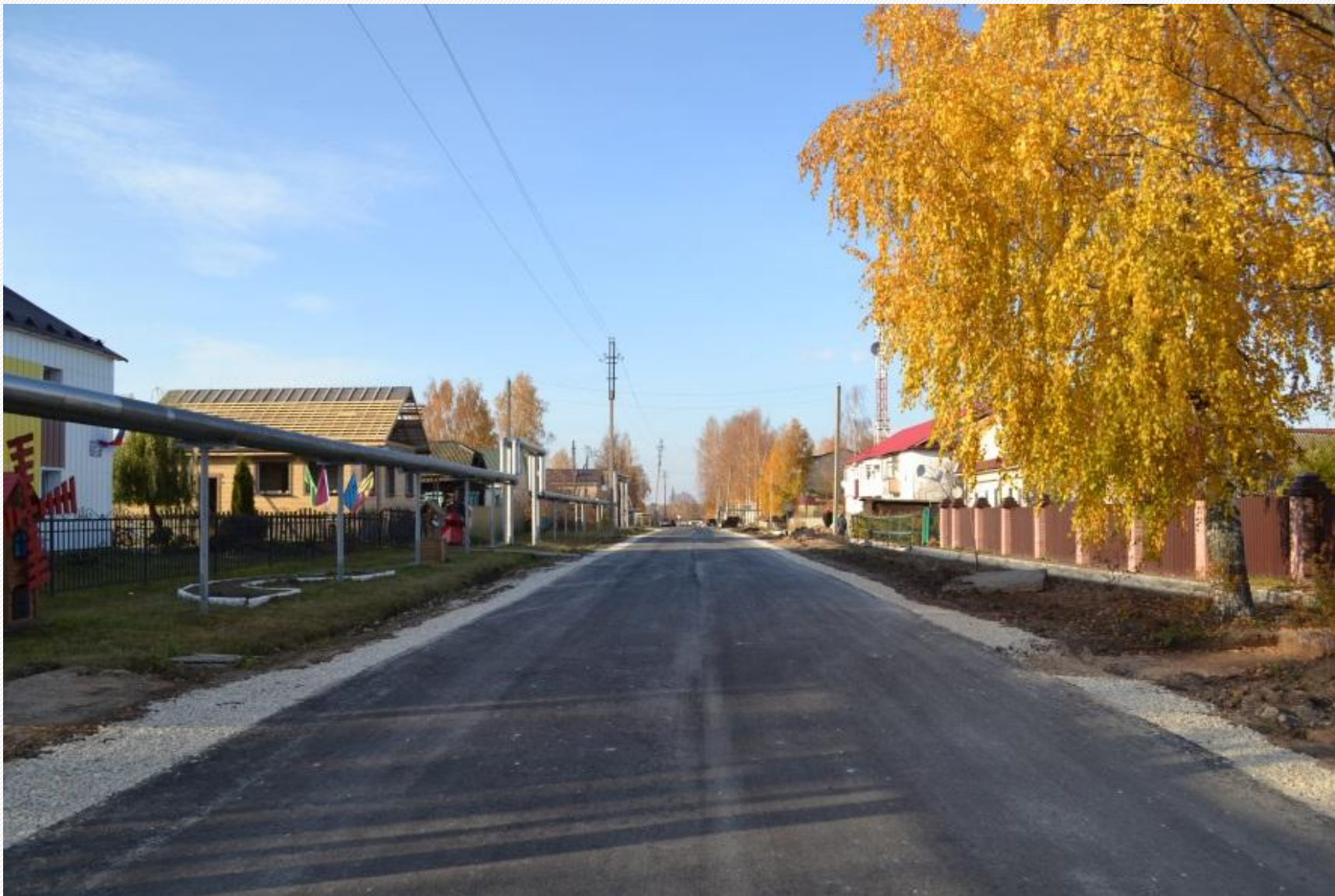
Ремонт асфальтобетонного покрытия на ул. Свободы в р.п. Тонкино
