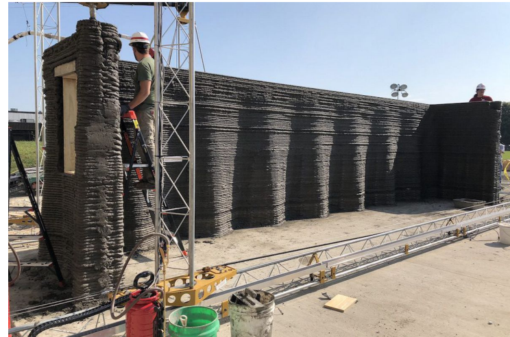
Использование 3D принтера на стройплощадке
