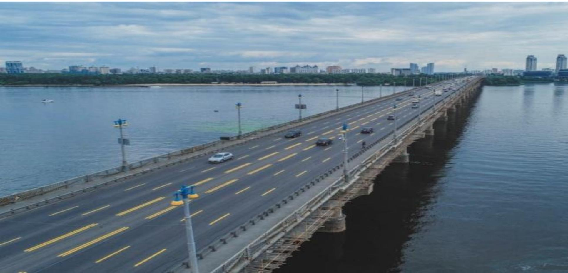
*путепровод* - инженерное сооружение мостового типа над другой дорогой (железной дорогой) в месте их пересечения, обеспечивающее движение по нему на разных уровнях и дающее возможность съезда на другую дорогу;
