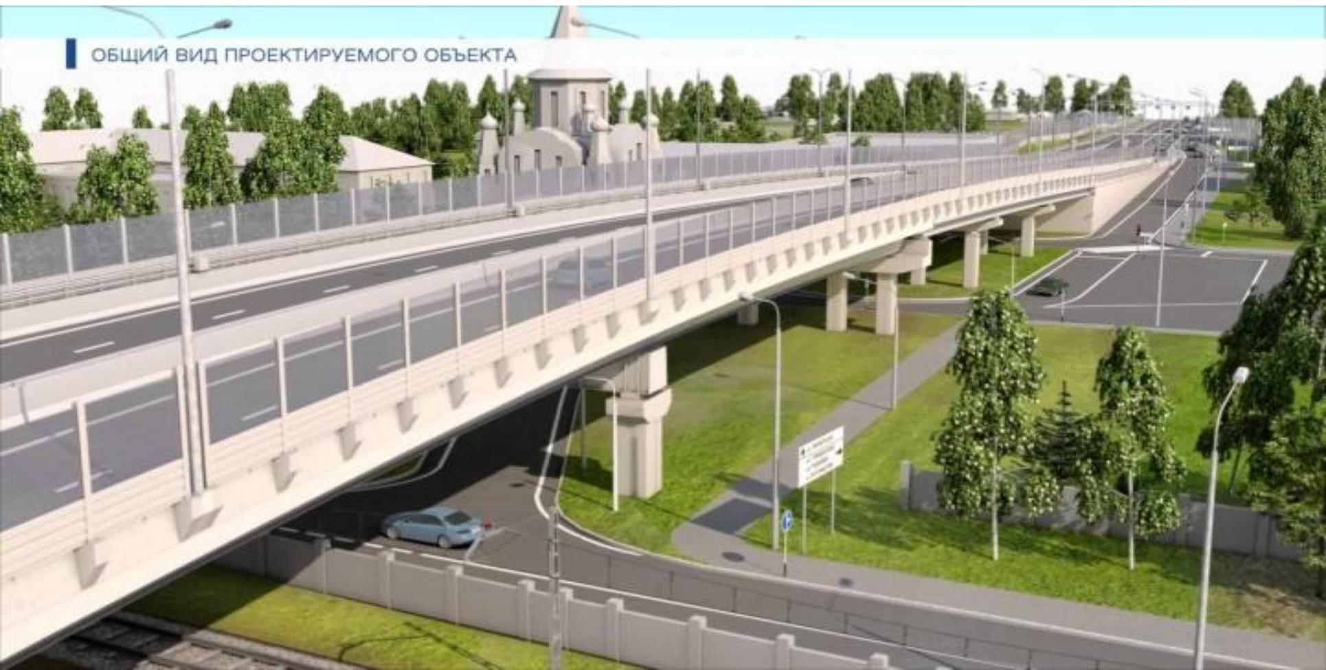
*эстакада* - инженерное сооружение для движения транспортных средств и (или) пешеходов, поднятия одной дороги над другой в месте их пересечения, а также для создания дороги на определенной высоте, которая не имеет съездов на другую дорогу.
