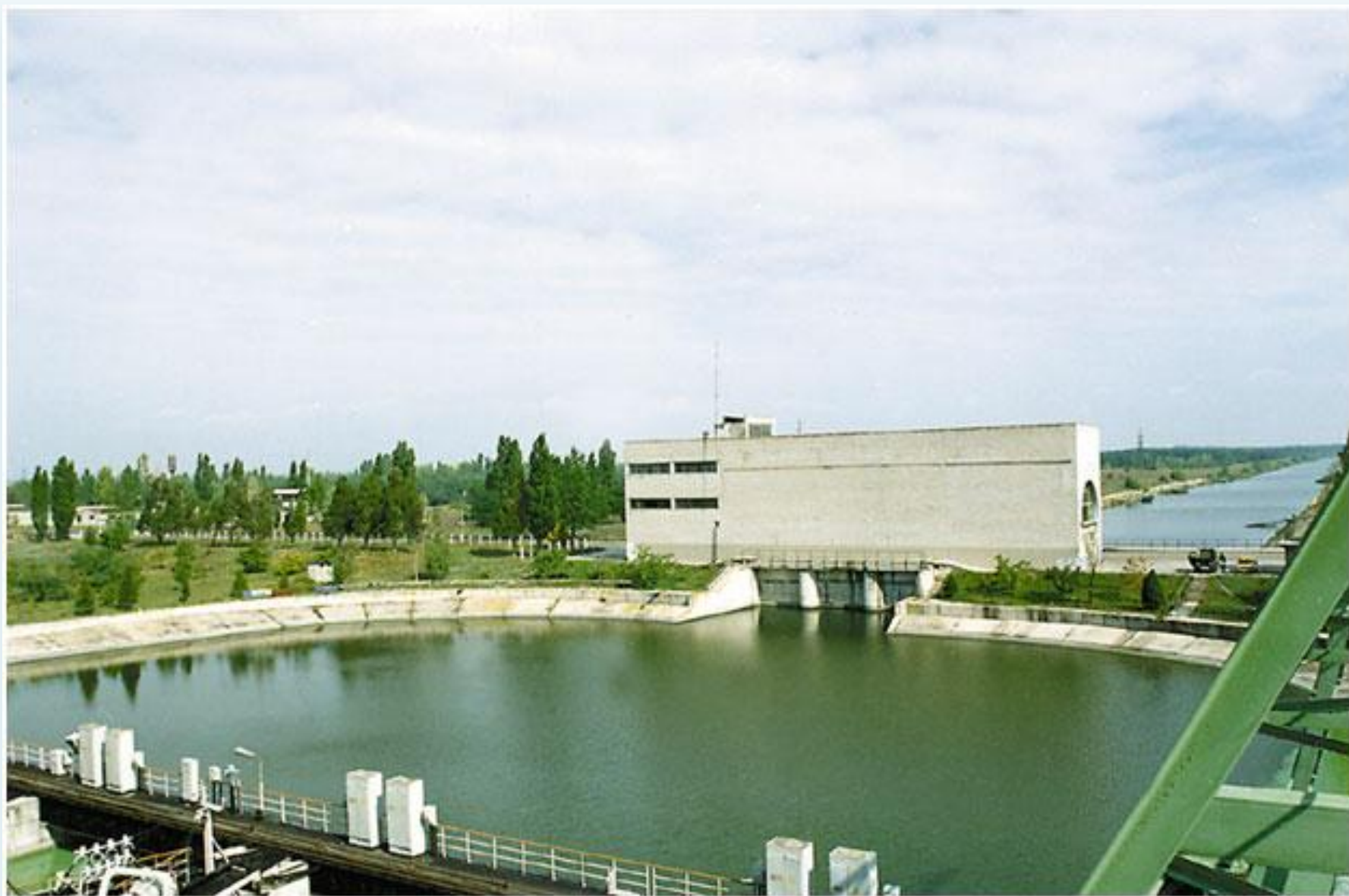
Водозабор на канале Днепр-Донбасс
