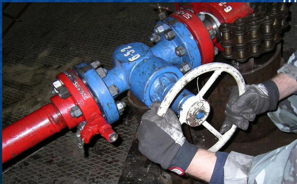
Подвести винтом подачи сверло к телу трубы и вращением штурвала с плавной подачей сверла произвести сверление отверстия в трубе. Вскрытие канала сверления контролируется манометром.
