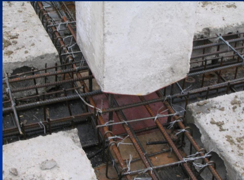
Армирование ригелей может выполняться в виде вязанных или сварных каркасов. Наиболее применяемые вязанные каркасы могут собираться как непосредственно на месте, так и внизу на столах или вообще вне площадки и подаваться на место установки краном. Верхняя надопорная арматура устанавливается на месте
