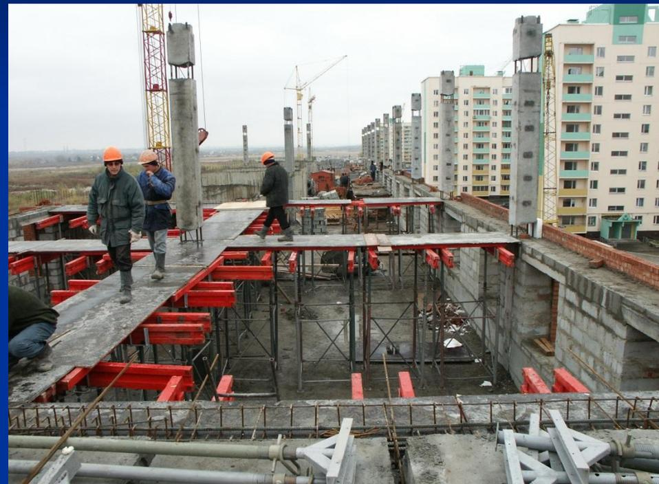
Поддерживающие устройства выполняют две основные функции - являются опорами для укладываемых плит перекрытия, а также опалубкой для монолитных ригелей. На правой фотографии наружная стена используется в качестве опалубки для крайнего ригеля
