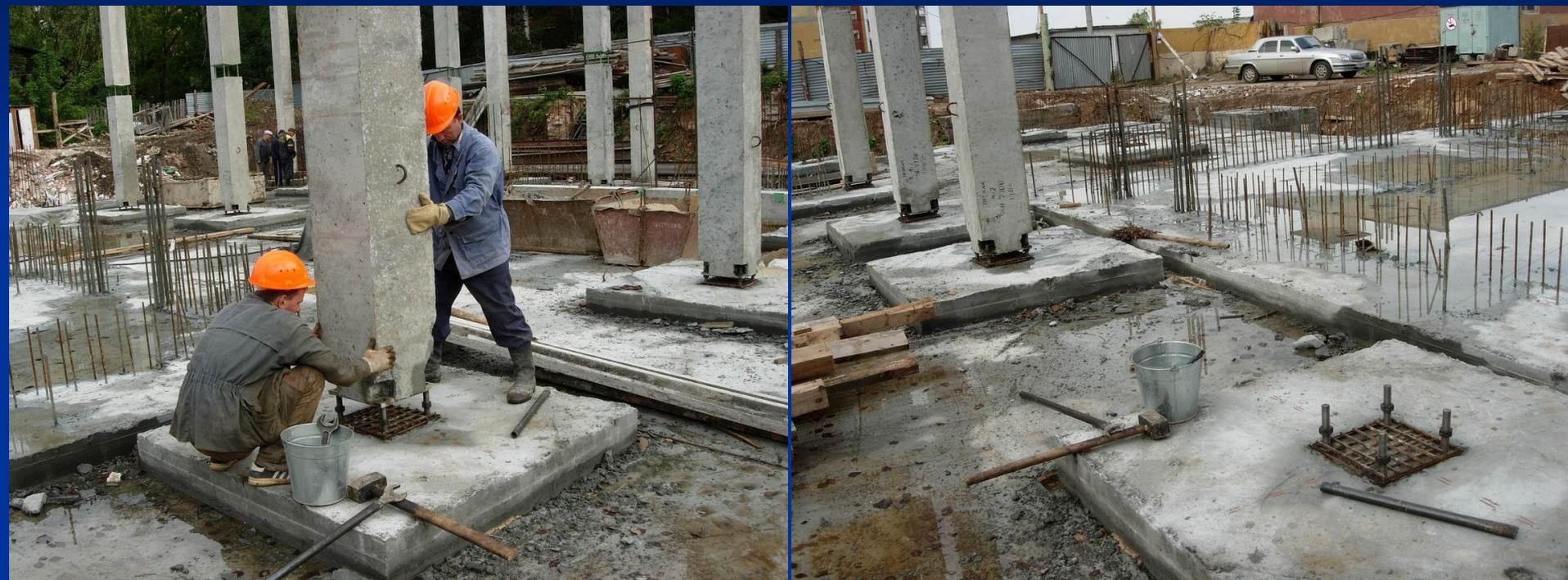
В это же время монтируются другие крупные сборные конструкции (это могут быть напр. железобетонные вентблоки и т.п.). Наружные стены этажа можно использовать в качестве опалубки для ригелей по контуру здания. В этом случае кладку наружных стен необходимо выполнить на этом шаге.
