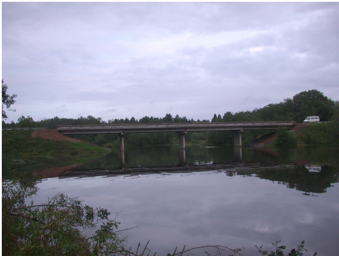
Рис. 1. Общий вид моста с левой стороны.
