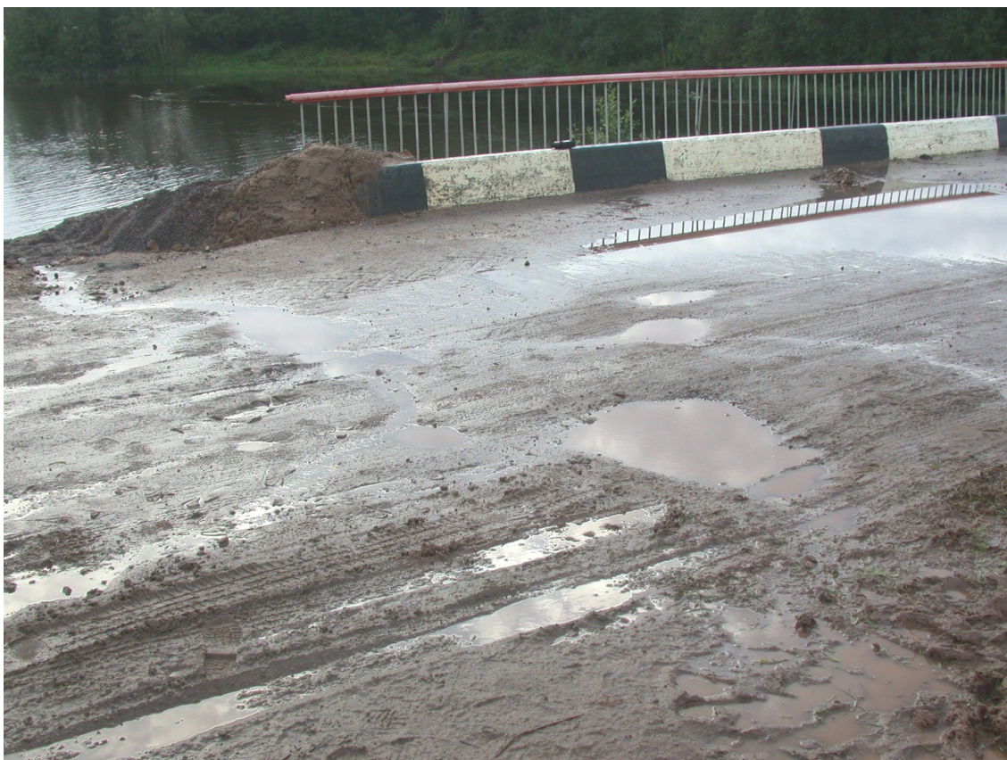
Рис. 16. Наносы грунта на проезжую часть на подходе №1.
