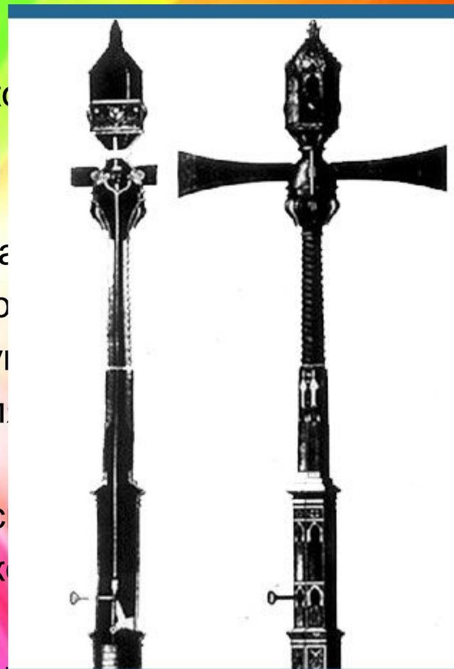
Когда стрелки располагались горизонтально, автомобилям запрещалось проезжать, а положение на 45 градусов означало разрешение движения.
