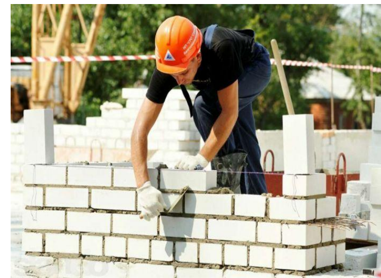
7. Строитель строит дом
