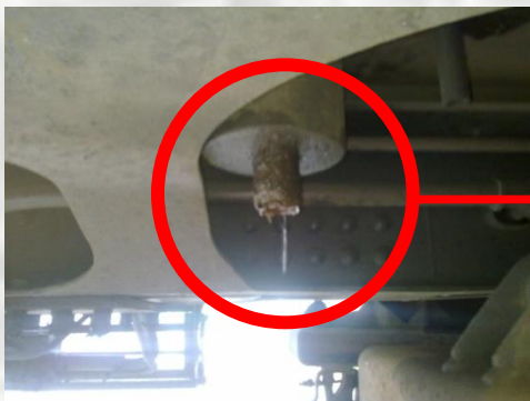
Пополнение водой системы отопления
