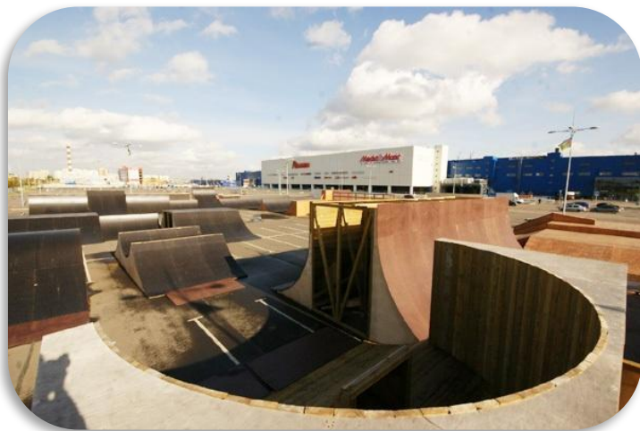
г. Санкт-Петербург, ТРК
