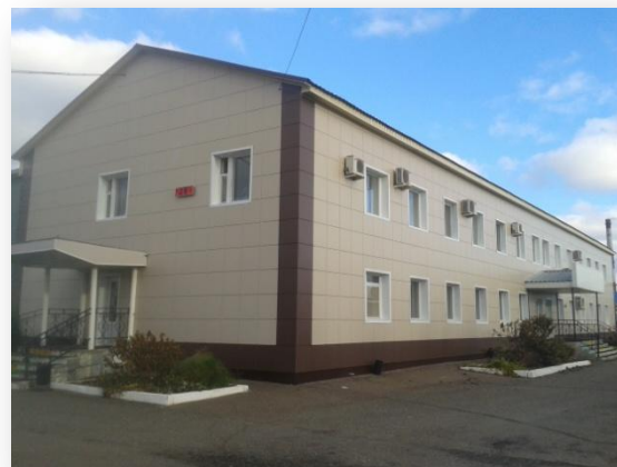
Административное здание в г.Нефтекамск
