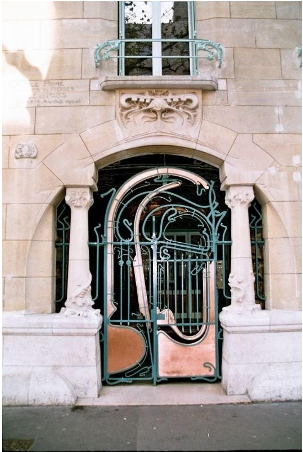
Решётка входных ворот в Castel Berange (архитектор – Г. Гимар, 1895-98)
