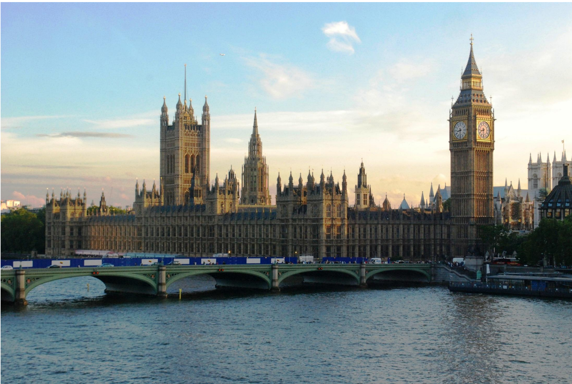
Вестминстерский дворец (архитекторы – Ч. Барри, О. Пьюджин; 1840-76)
