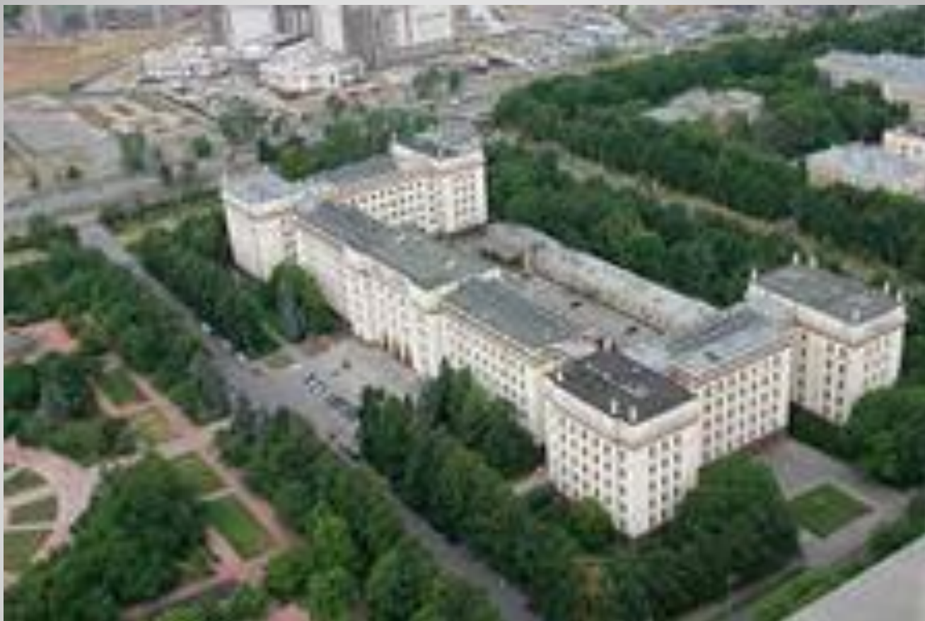
Химический корпус (здание ХФ МГУ)
