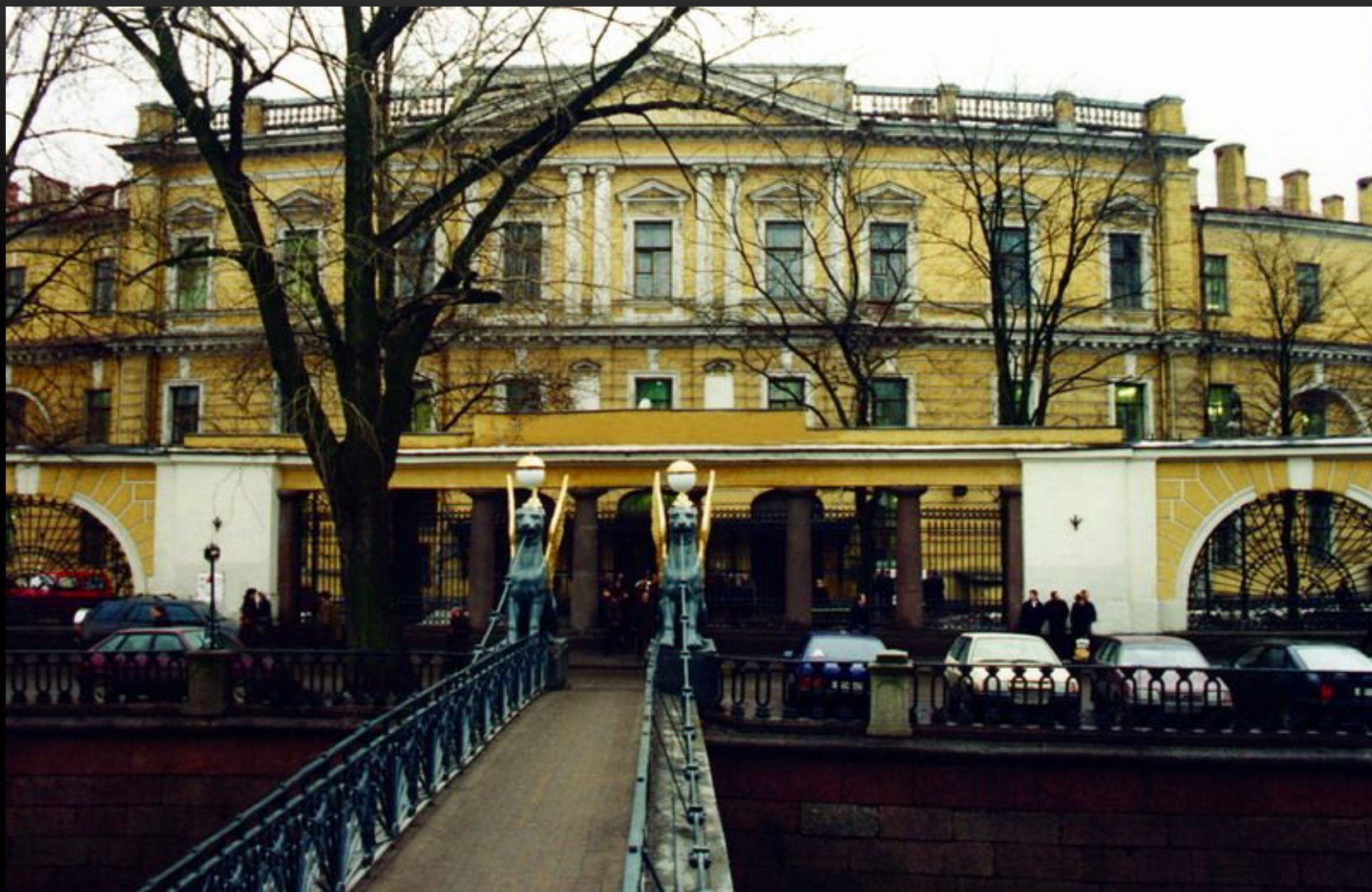
Государственный ассигнационный банк. Вход в здание банка со стороны Банковского моста
