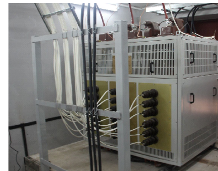
Силовой трансформатор 10/0,4 кВ ТСЗН-400 кВА
