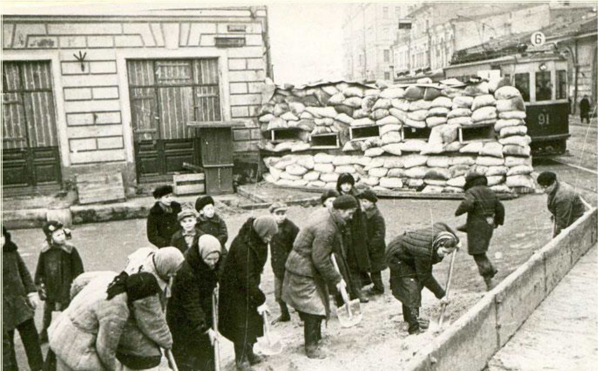
Москвичи на строительстве баррикад на окраине города. 1941 г.
