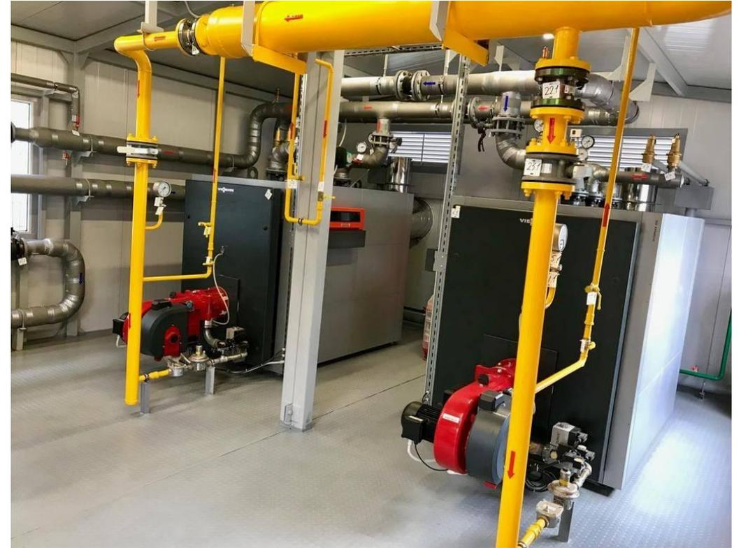
Внутри сооруженного корпуса размещаются технологическое оборудование котельной и трубопроводная система. Состав оборудования, которым комплектуются блочно-модульные котельные, может варьировать в зависимости от вида топлива и типа используемого котла.
