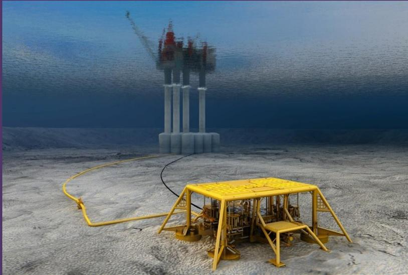
По сложности подводные комплексы могут варьировать от одной скважины, называемой сателлитной, до нескольких скважин в темплете или сгруппированных около манифольда. С помощью сборного манифольда продукция со скважин может транспортироваться либо на береговые сооружения, если до берега относительно недалеко, либо на морское судно или безопасно отстоящую платформу, где производятся дополнительные технологические процессы по подготовке газа или нефти.
