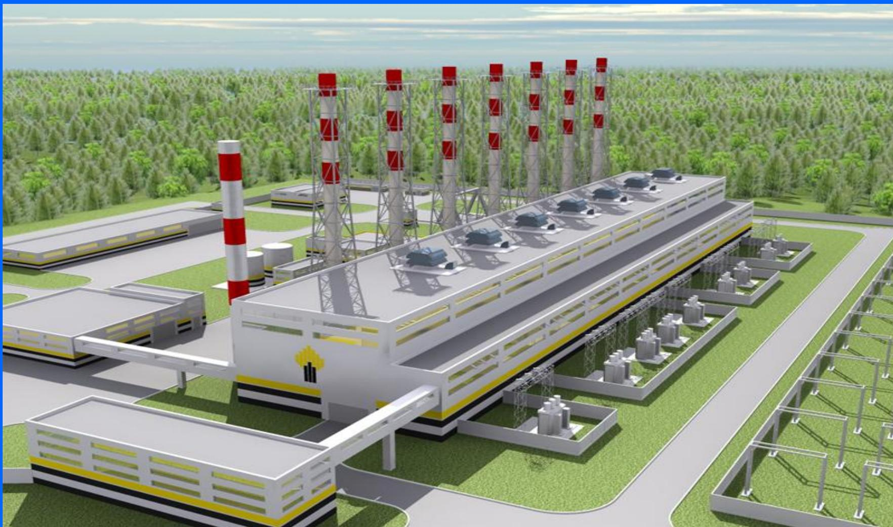
4) Государственные районные электрические станции (ГРЭС), оборудованы специальными конденсационными турбинами. Они не используются для выработки тепла и обогрева зданий. Эти электростанции называют конденсационными.
