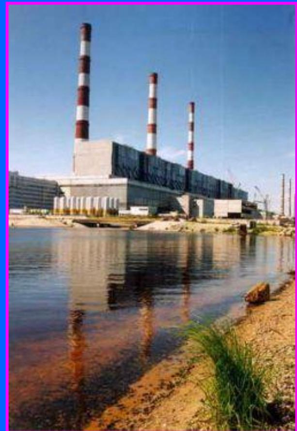
5) **Теплоэлектроцентрали (ТЭЦ)** имеют теплофикационные турбины, которые преобразуют вторичную энергию отработанного пара в тепловую энергию. Это тепло используют для обогрева зданий в коммунальном хозяйстве и для промышленных служб.
