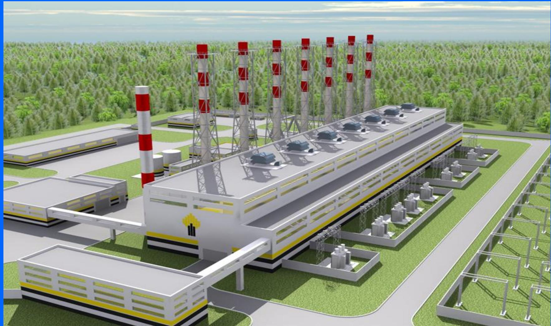
**4) Государственные районные электрические станции (ГРЭС)**, оборудованы специальными конденсационными турбинами. Они не используются для выработки тепла и обогрева зданий. Эти электростанции называют конденсационными.
