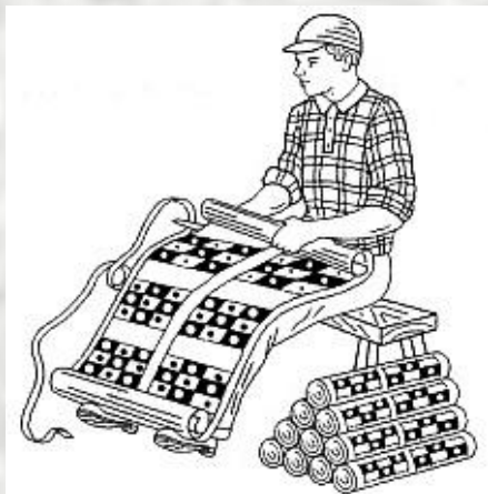
Обрезка кромок обоев
