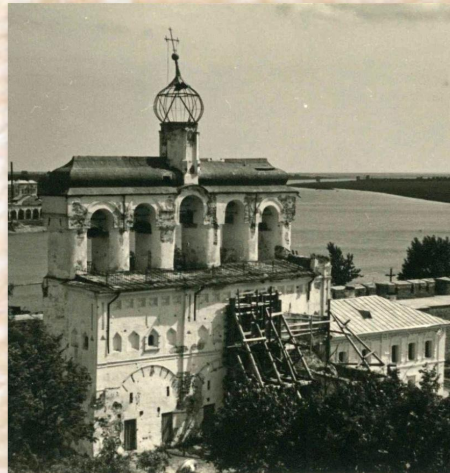
Звонница Софийского собора. Разрушения. Фото 1947 г.
