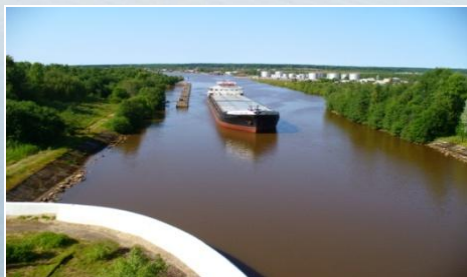
Самый насыщенный гидросооружениями участок Волго- Балтийского водного пути
