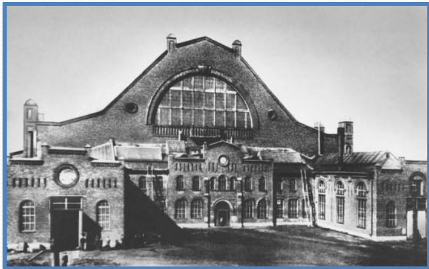
Путиловский завод. Здание башенной мастерской. Фото начала XX в
