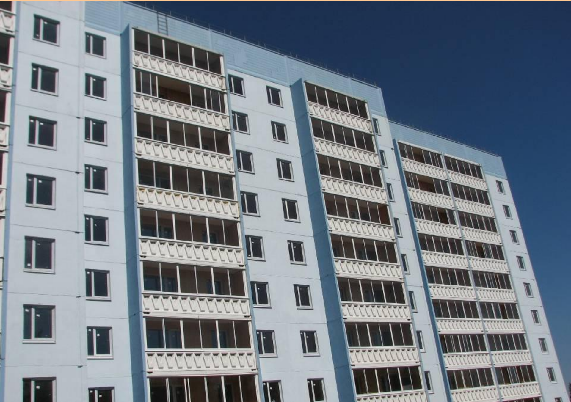
113-кв жилой дом по Ключевскому шоссе, МУП «УКС»
