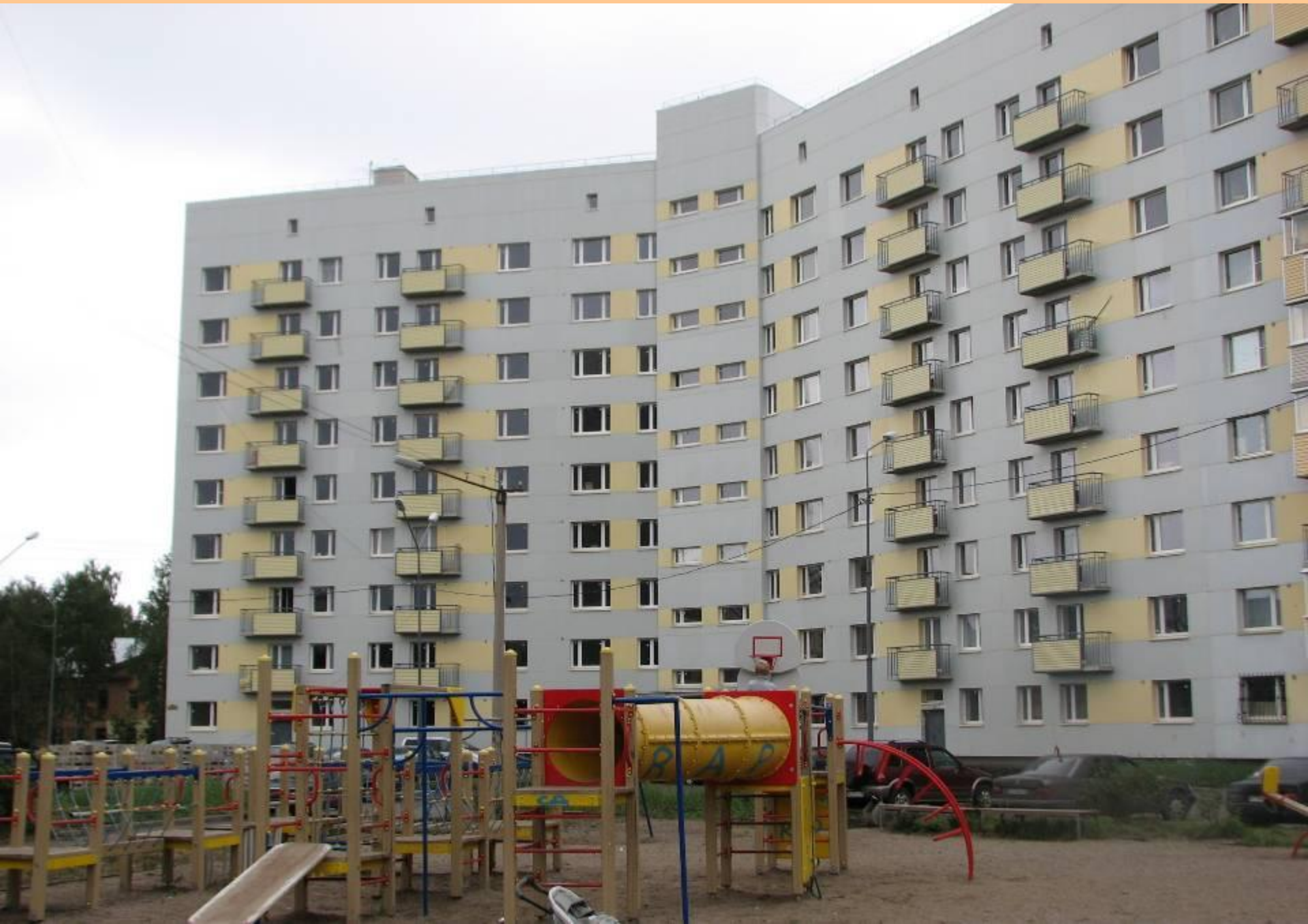
105-кв жилой дом по пр. Октябрьскому, ЗАО «КСМ»
