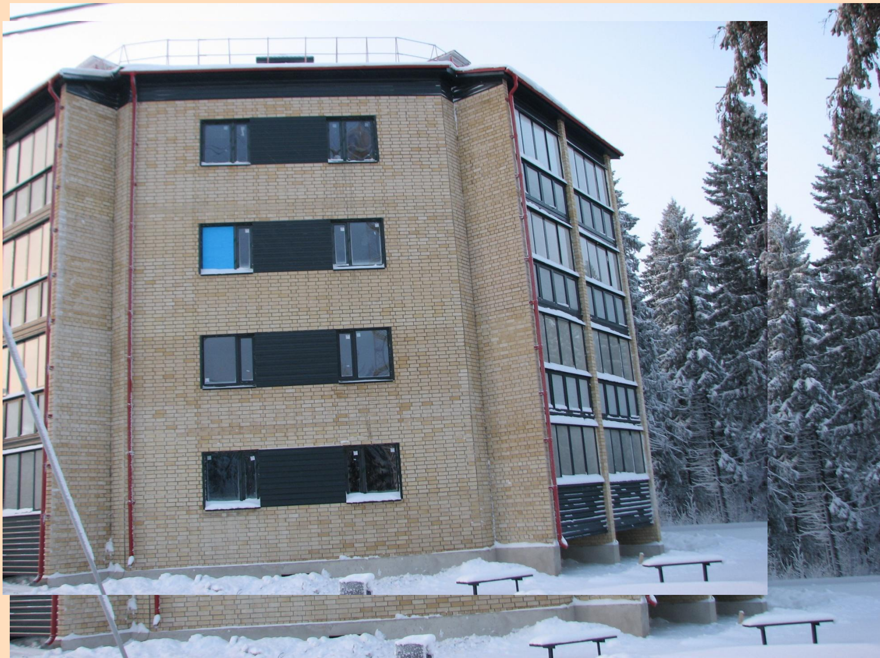
19-кв жилой дом по ул. Парковая, МУП «УКС»
