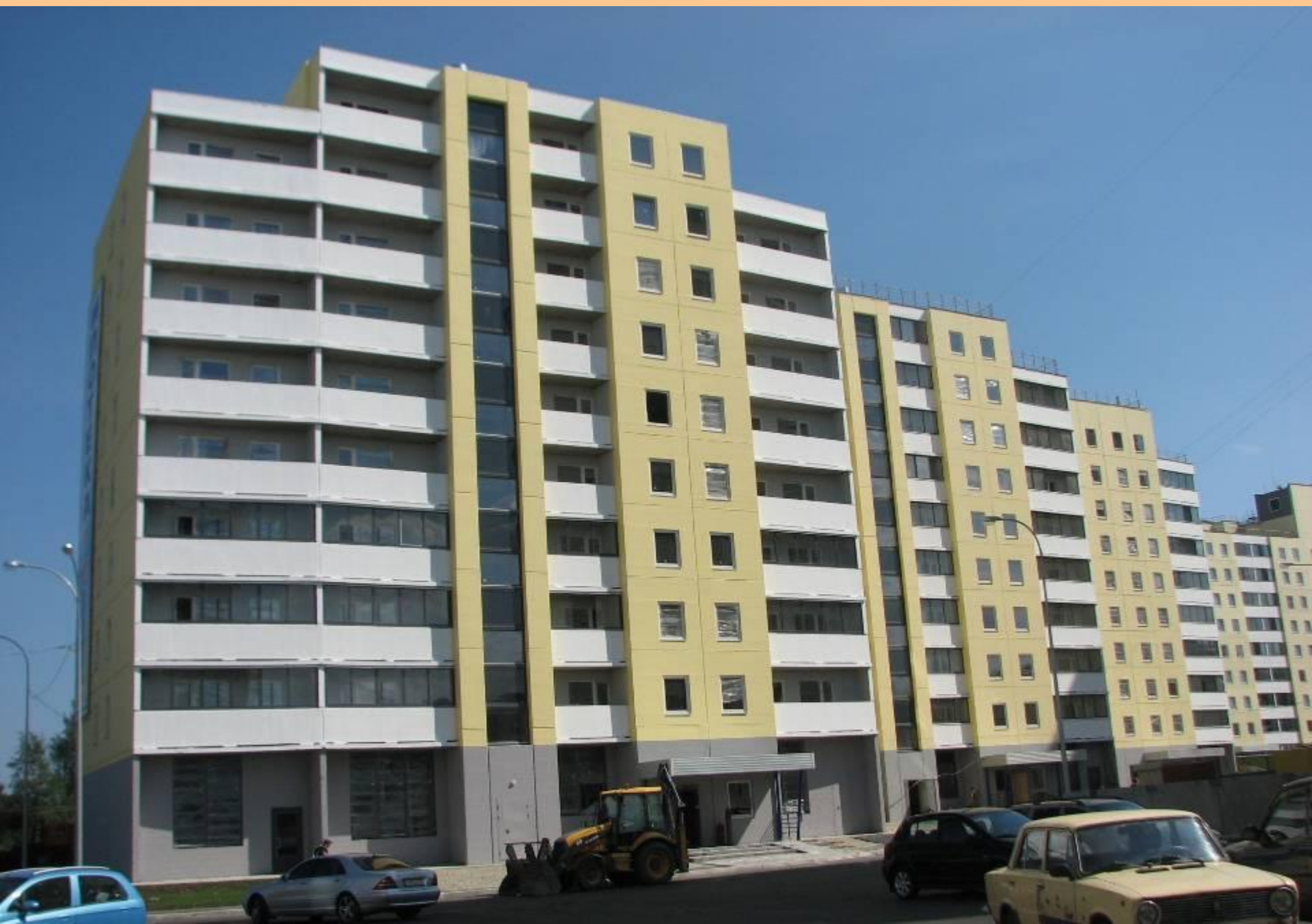
206-кв жилой дом по ул. Правды, ООО «САНА»
