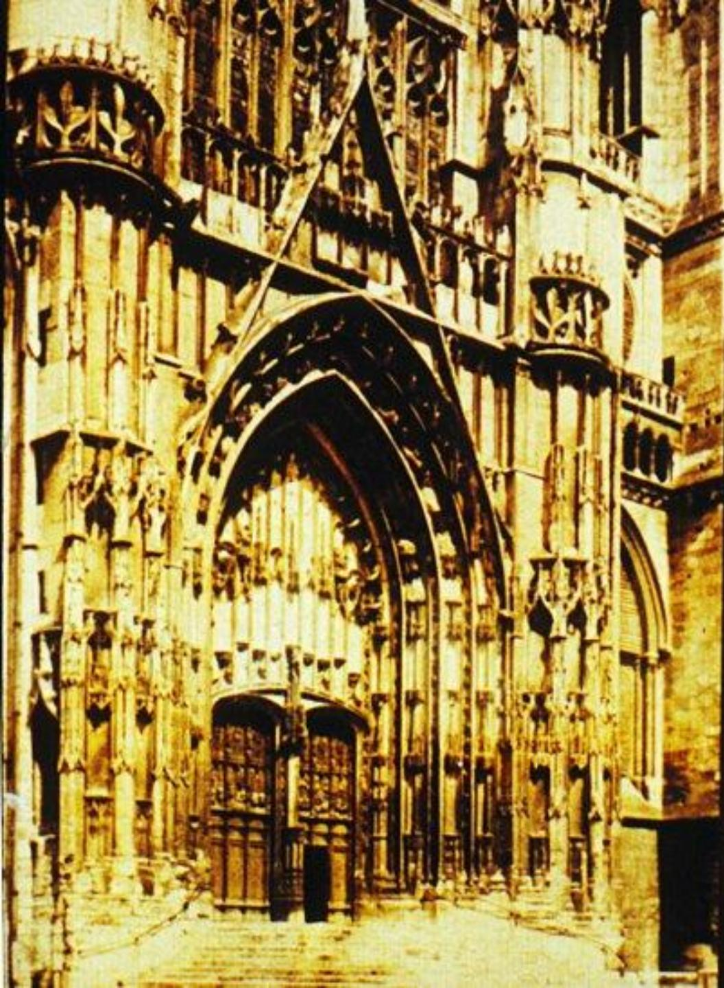
**ПОРТАЛ** – декоративно оформленный дверной проем здания. Перспективный портал – обрамление входа в виде ряда уходящих в глубину стены уступов.
