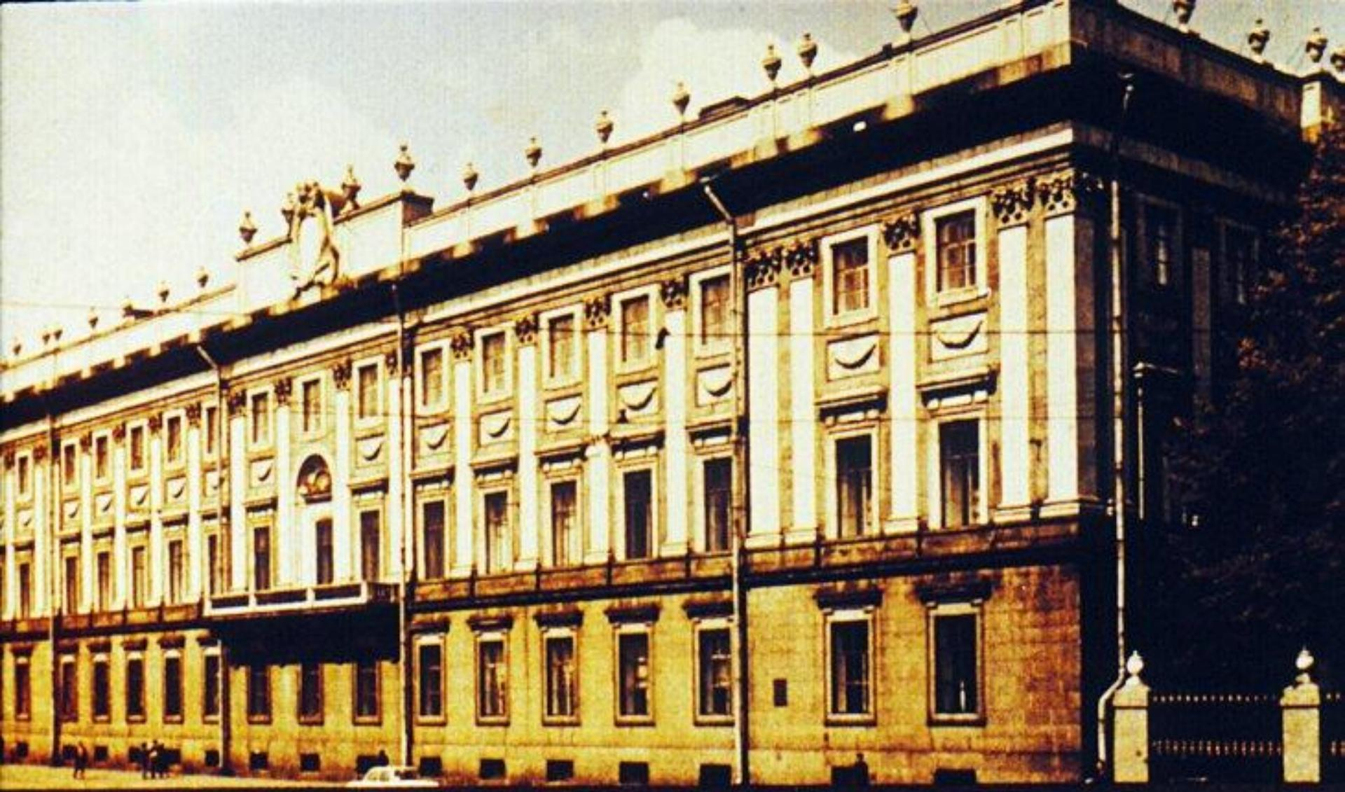
**ПИЛЯСТРА**—прилегающий к стене, соразмерный ей плоский выступ с членениями колонны — имеет базу, ствол, капитель. Использовалась в качестве конструктивного элемента, усиливающего стену, или как декоративный элемент.
