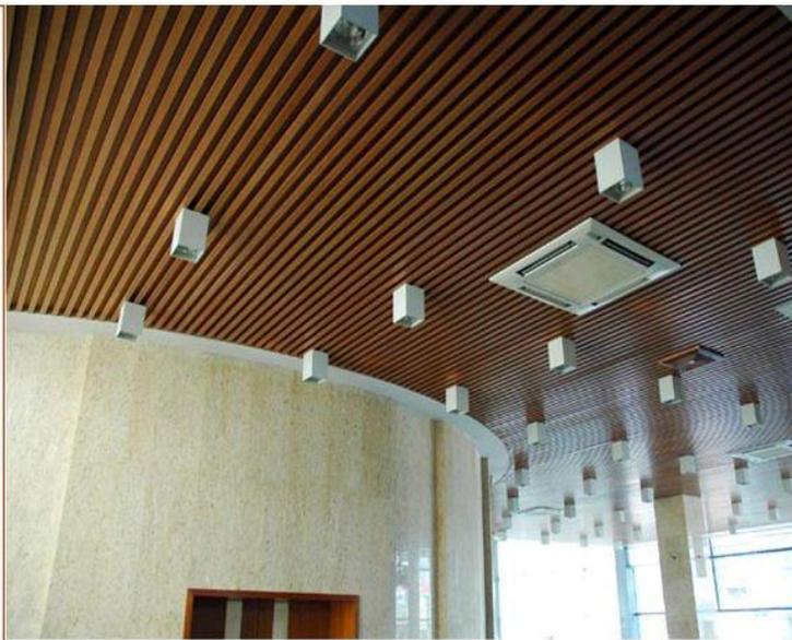
Использование легкого и прочного пустотелого профиля из древесно-полимерного композиционного материала позволяет создавать конструкции значительных размеров, не перегружая при этом несущие элементы зданий и сооружений.
