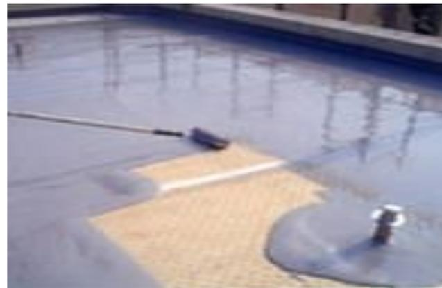
**Мастичные полы** - это монолитные половые покрытия на основе полимеров. Мастики имеют консистенцию сметаны и содержат жидкий полимер, наполнители и пигменты. Наносят их на сплошное сухое основание пола слоем 0,5...1 см, после твердения в течение 1...2 суток образуется сплошное бесшовное покрытие пола.
