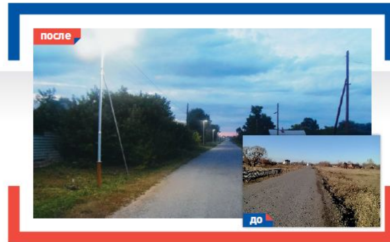
2020 Монтаж уличного освещения – 1 496 тыс. рублей
