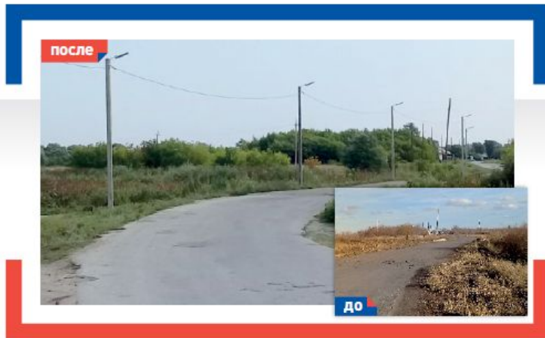
2019 Монтаж уличного освещения – 1 275 тыс. рублей
