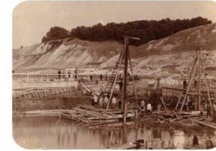
Земляные работы проводились практически полностью вручную. По берегам канала с помощью чугунной «бабки» устанавливали плотины. При помощи блочной системы ее поднимали, затем опускали, чтобы забить сваи. Шлюзы покрывали деревянными досками из дуба
