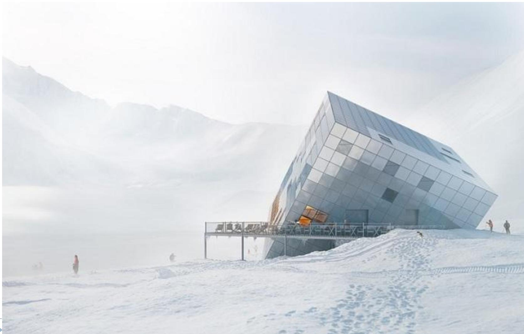
Фасад отеля будет состоять из квадратов (размером 1х1 метр), сделанных из светоотражающих материалов: алюминия, стекла и фотоэлектрических панелей. С точки зрения производства и потребления энергии Kezmarška Hut разработан как пассивное здание. Оригинальная форма и месторасположение способствуют попаданию солнечных лучей на всю его поверхность.
