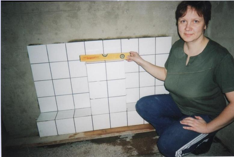
Служит для установки и проверки горизонтальности и вертикальности облицовываемой поверхности. Корпус уровня может быть изготовлен из дерева, легкого металла или искусственного материала. Его длина может быть от 15 см до 2 м.
