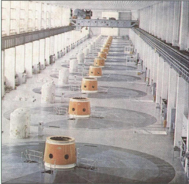
Машинный зал ГЭС
