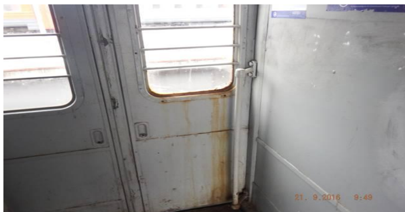
Ржавчина на автоматических дверях.
