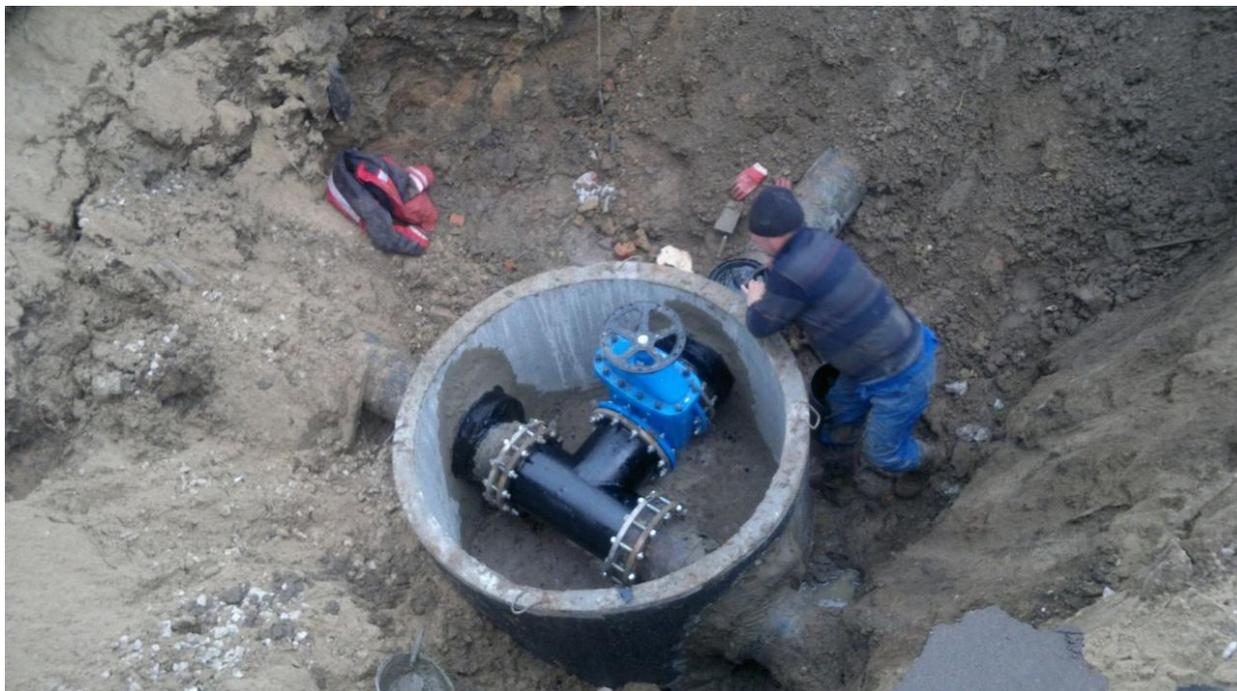
Так примерно выглядит процесс ремонта трубопроводной арматуры в колодец
