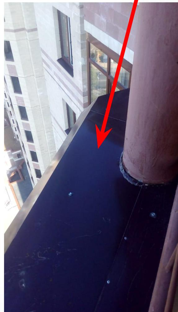
Отдельных больших работ потребовала гидроизоляция технического балкона 1 подъезда с устройством системы водоотведения с согревающим кабелем. Этот балкон изолирован и практически недоступен для проведения работ, поэтому основной проблемой являлась доставка к нему строительных материалов.
