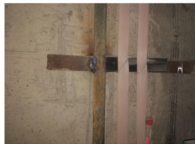
*монтаж и крепление заземления и проводки*
