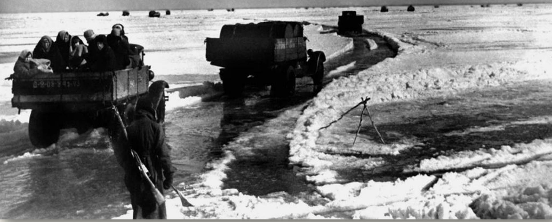
**Учёный смог определить оптимальную скорость движения, нагрузку и расстояние между машинами, чтобы ни одна из них не смогла вызвать губительный резонанс и пролом льда.**
