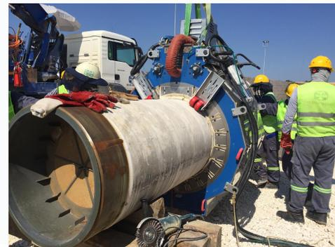
До начала производственного периода ООО «СПК-Магистраль» провела аттестацию технологии сварки в соответствии с требованиями DNV-OS-F101-2010 (Морской стандарт для подводных трубопроводных систем).
