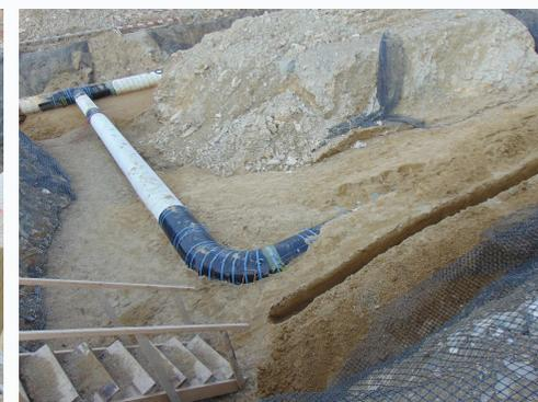
Объем работ: геодезическая разбивка и подготовка участка строительства, разработка траншеи, общестроительные работы, сварка и монтаж перемычек Ø24" - Ø32", неразрушающий контроль, нанесение изоляции на сварные соединения, восстановление изоляционного покрытия трубопровода, укладка трубопровода, обратная засыпка, монтаж системы ЭХЗ, проведение гидравлических испытаний, восстановление нарушенных земель.
