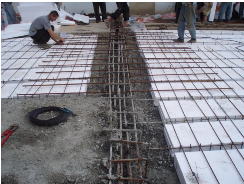
Улаштування плоского монолітного залізобетонного перекриття
