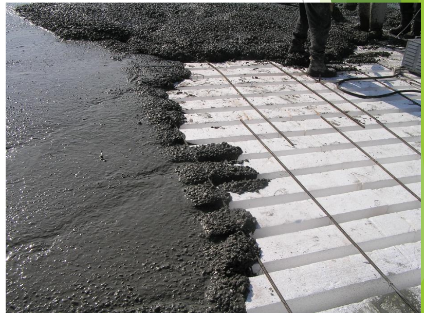
Влаштування плоского монолітного залізобетонного порожнистого перекриття розмірами в плані 7,6×12,1 м
