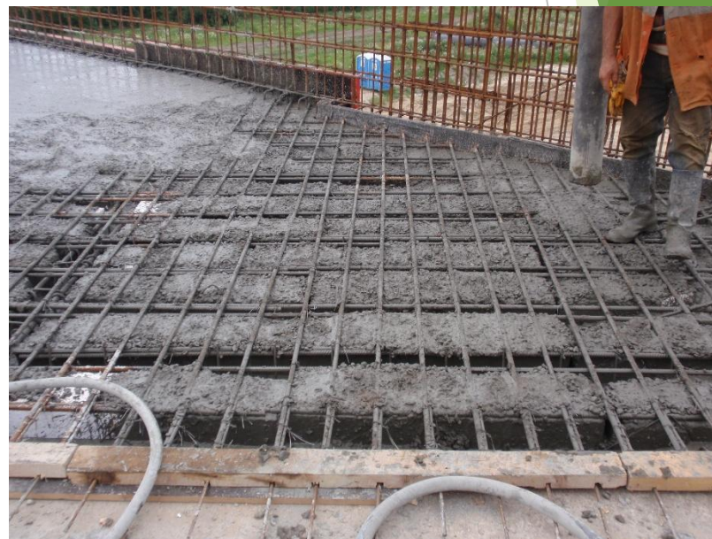
Улаштування монолітної ділянки з пінополістирольними вставками
