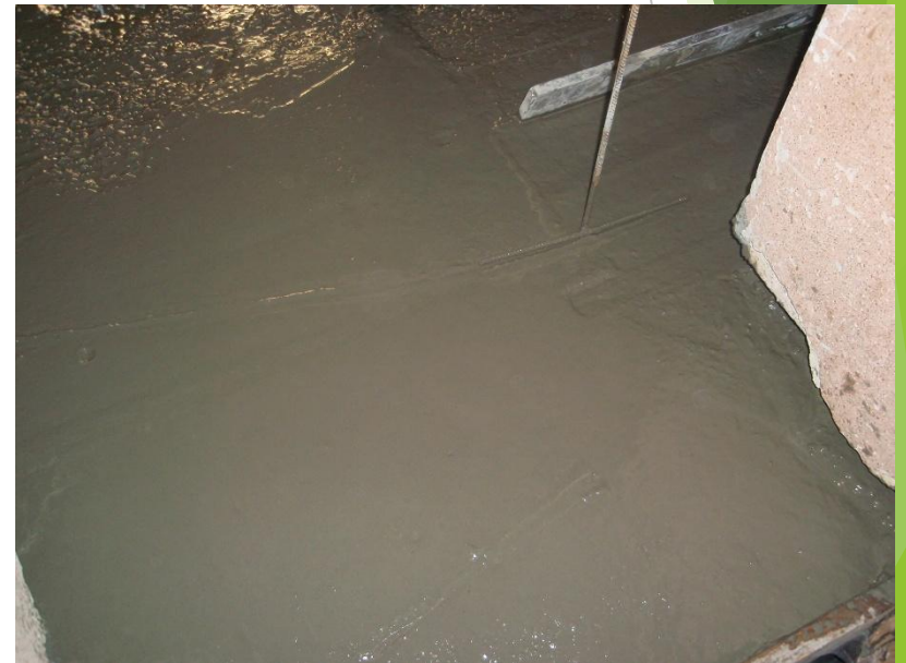
Влаштування плоского монолітного залізобетонного порожнистого перекриття при реконструкції перекриття над підвалом
