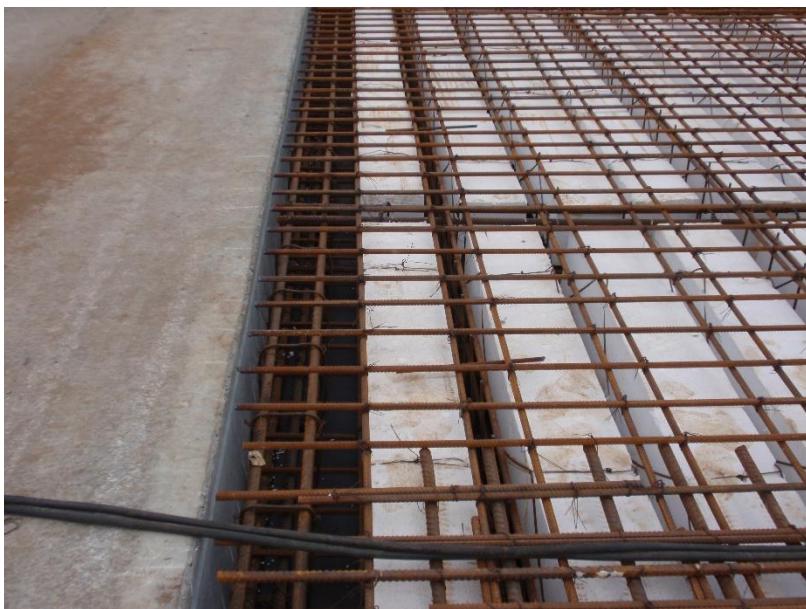
Улаштування монолітної ділянки з пінополістирольними вставками
