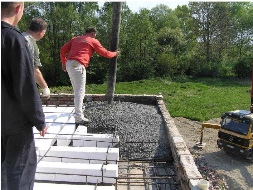
Влаштування плоского монолітного залізобетонного порожнистого перекриття розмірами в плані 7,6×12,1 м
