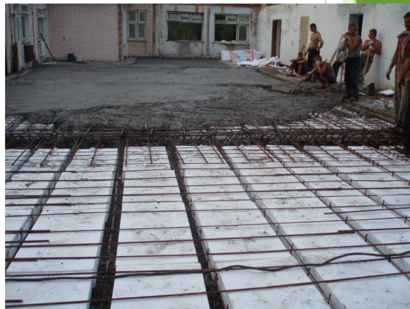
Улаштування плоского монолітного залізобетонного перекриття
