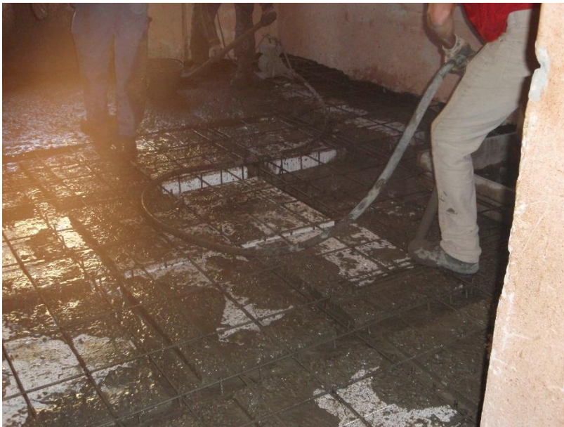
Влаштування плоского монолітного залізобетонного порожнистого перекриття при реконструкції перекриття над підвалом
