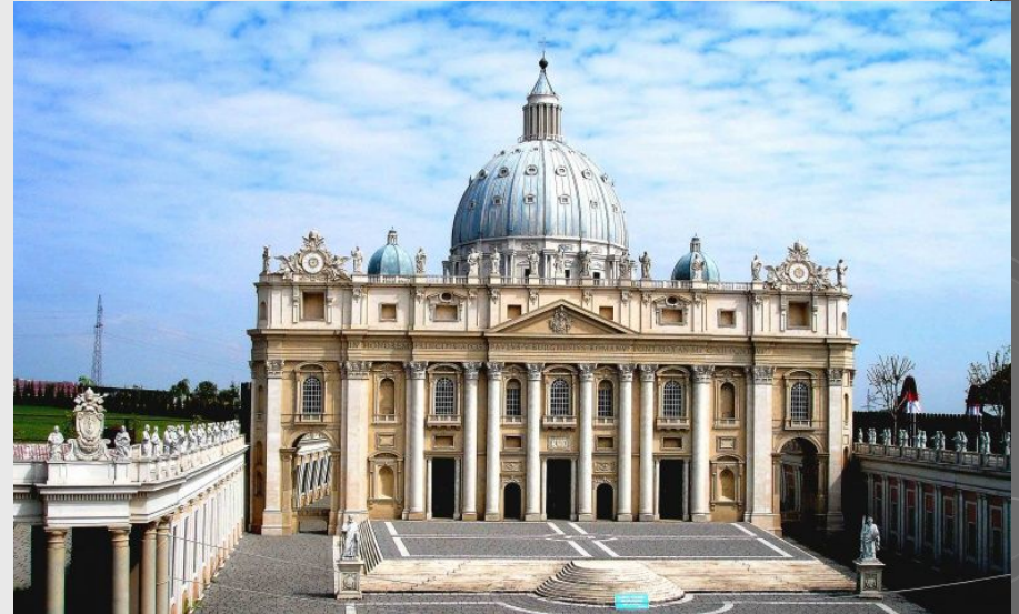
Собор святого Петра в Риме. Построен по проекту Донато д' Анжело Браманте.
