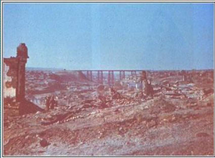
Разрушения в Сталинграде, октябрь 1942г.
