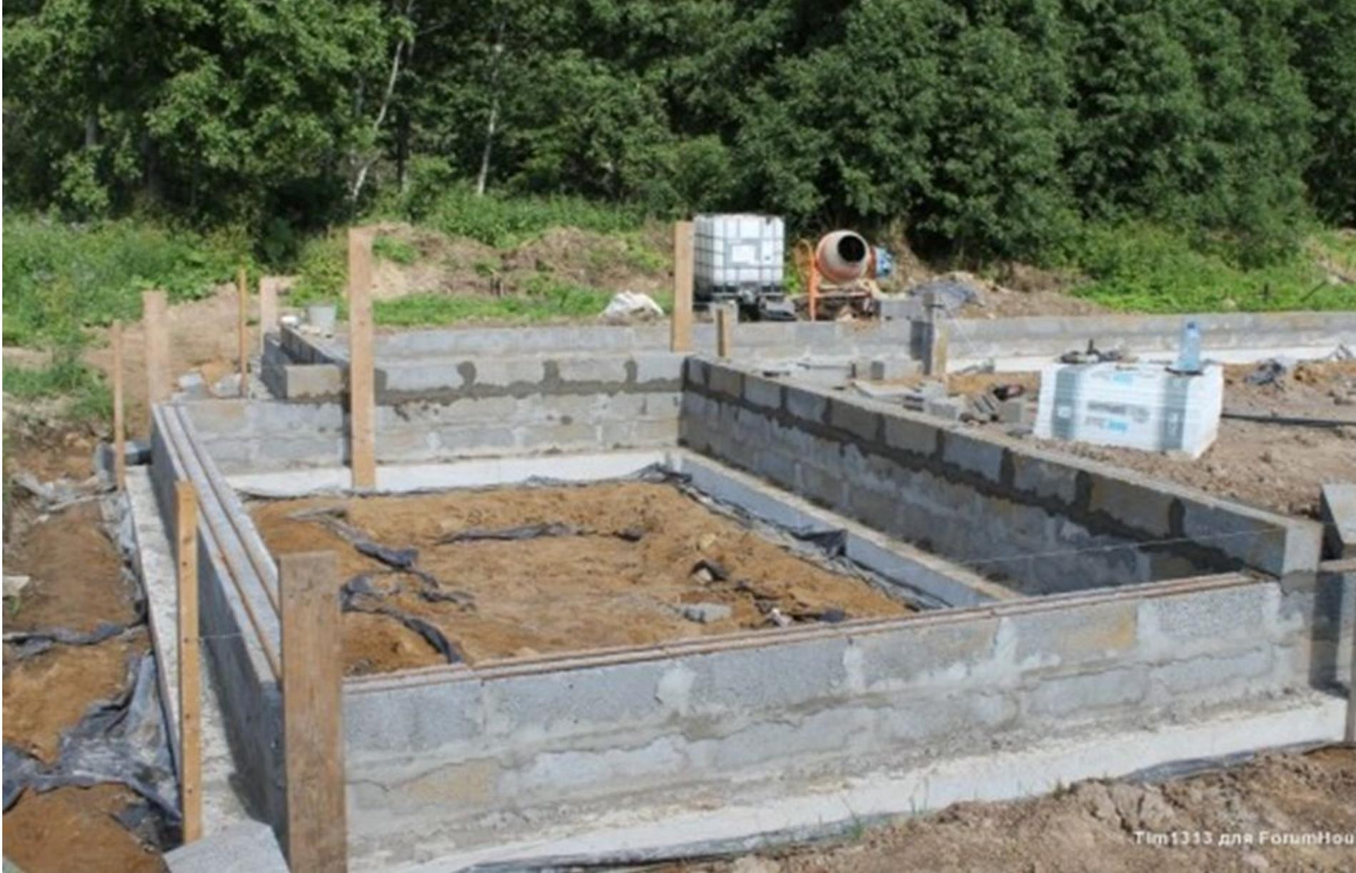
**Утеплённый финский фундамент (УФФ) — это утепленная лента с «опорной пяткой», выполняющей опорную и несущую роль, с обратной засыпкой хорошо утрамбованным грунтом, и хорошо утепленной стяжкой с теплоизоляцией.**
