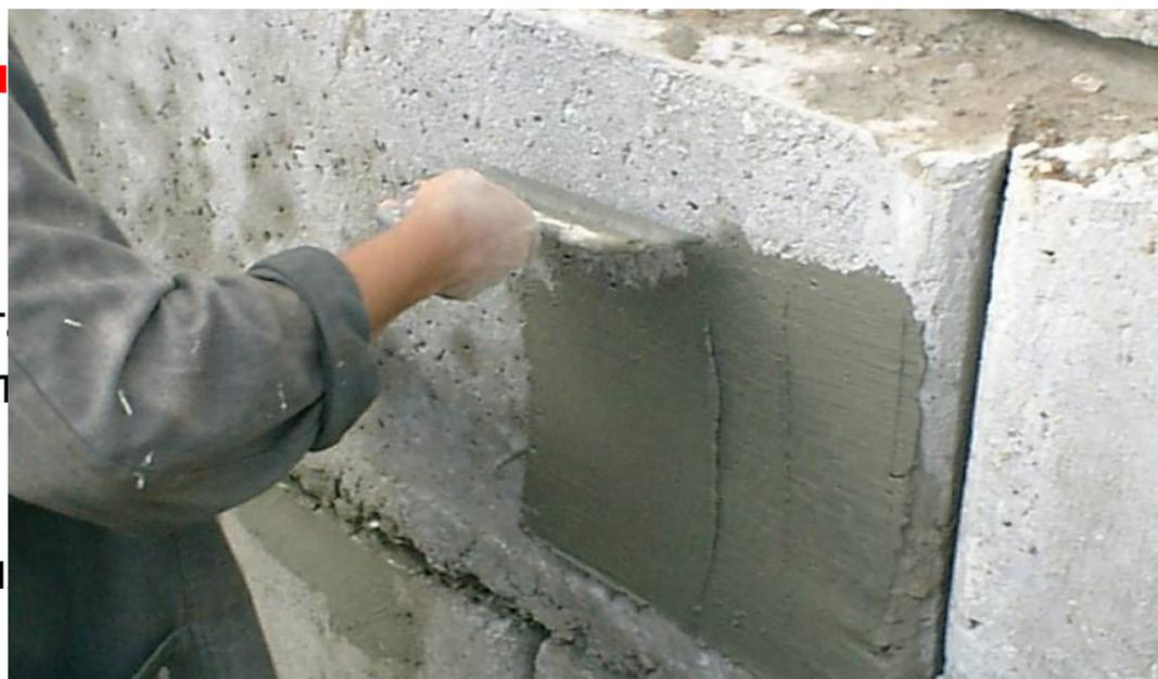
**Окрасочная.** Окрасочная гидроизоляция бывает горячей или холодной и предусматривает нанесение сложного слоя толщиной 1-1 мм из защитных средств. Самыми подходящими среди них являются **горячие полимерно-битумные и холодные эпоксидно-каучуковые покрытия.**
