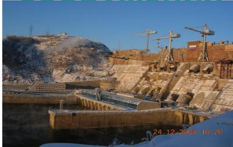
Рис. 1.2. Строительство Бурейской ГЭС с гравитационной бетонной плотиной с использованием укаганного бетона
