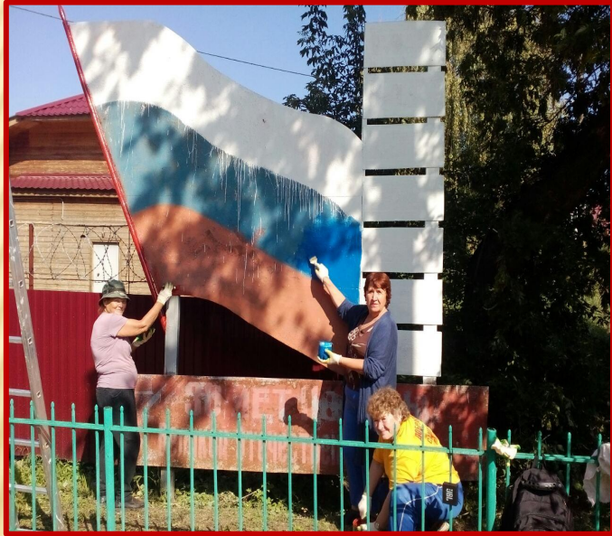
Ремонт стелы (2019г.)
