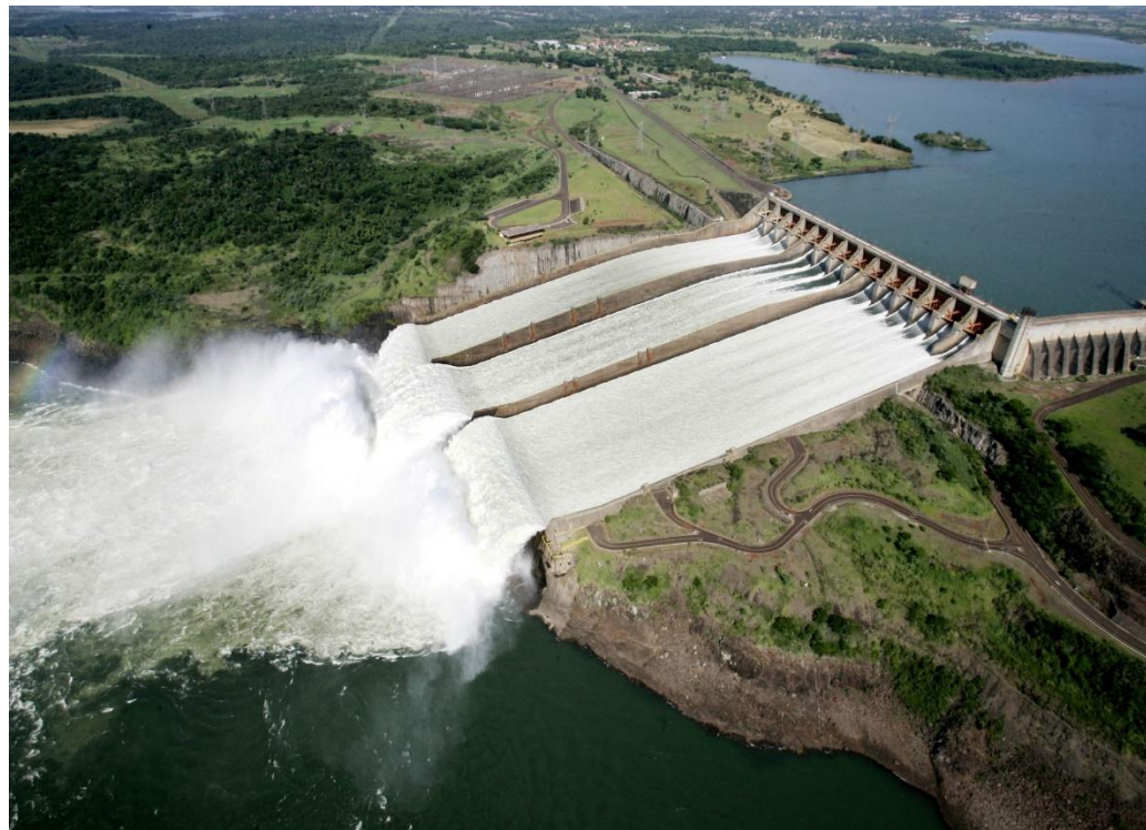
Гидроэлектростанция Итаипу - самая большая в мире до 2012 года
