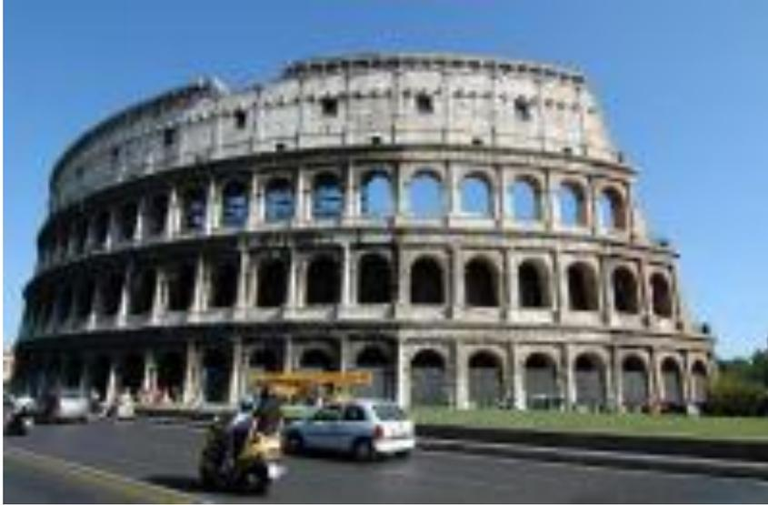
Оригинальным (незаимствованным извне) элементом римской архитектуры являлась т.н. римская **арочно-ордерная ячейка**, сочетающая в себе элементы арки и ордера. Используя арочно-ордерную ячейку римляне возводили триумфальные арки и амфитеатры.
