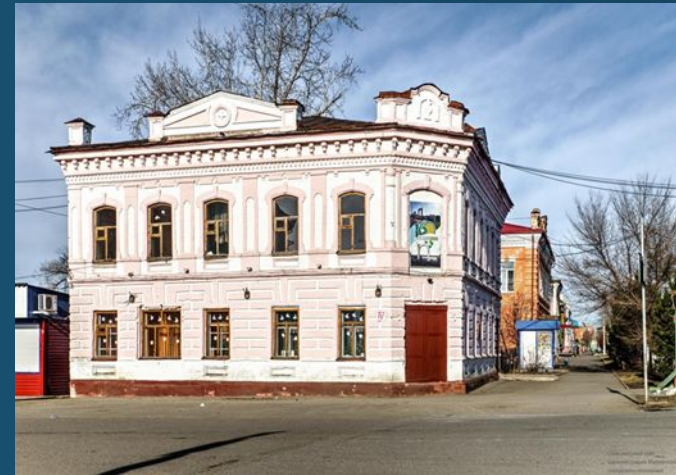
Здание администрации Мариинского городского поселения
