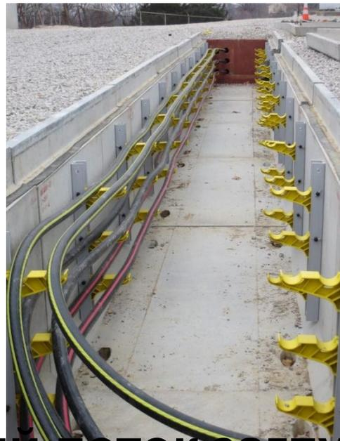
**Кабельный лоток заглублен в грунт типа**
