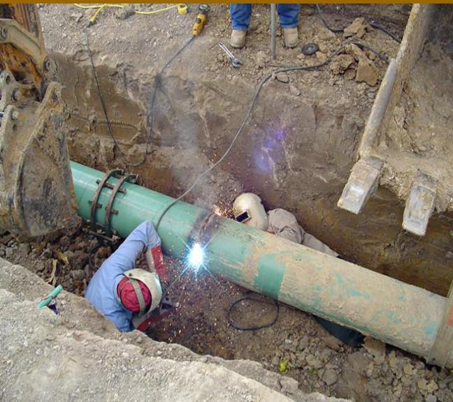
✓ При небольшой толщине стенок сварка труб производится без скоса кромок, при большей толщине создают скос в 70-80 градусов.
