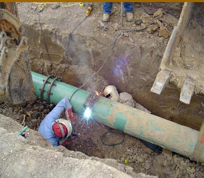
При небольшой толщине стенок сварка труб производится без скоса кромок, при большей толщине создают скос в 70-80 градусов.
