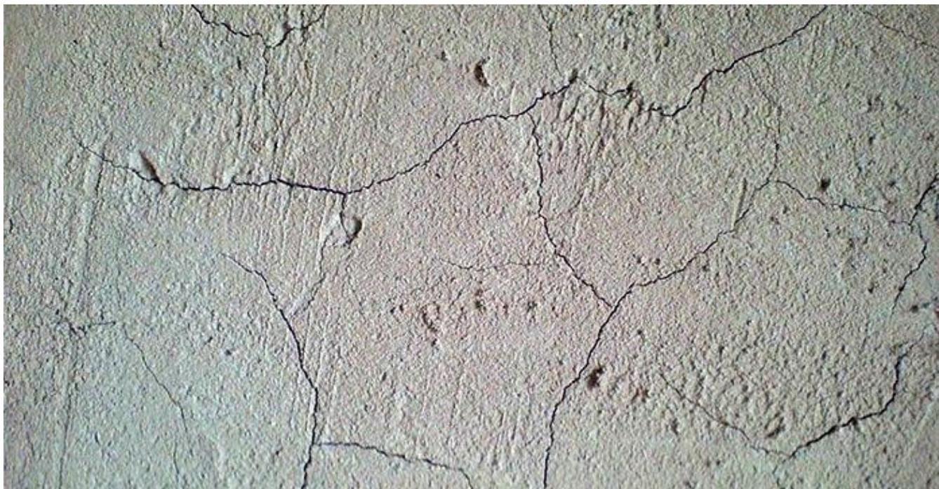
□ неудовлетворительно - имеются повреждения, дефекты и трещины, свидетельствующие об ограничении работоспособности и снижении несущей способности конструкций.
